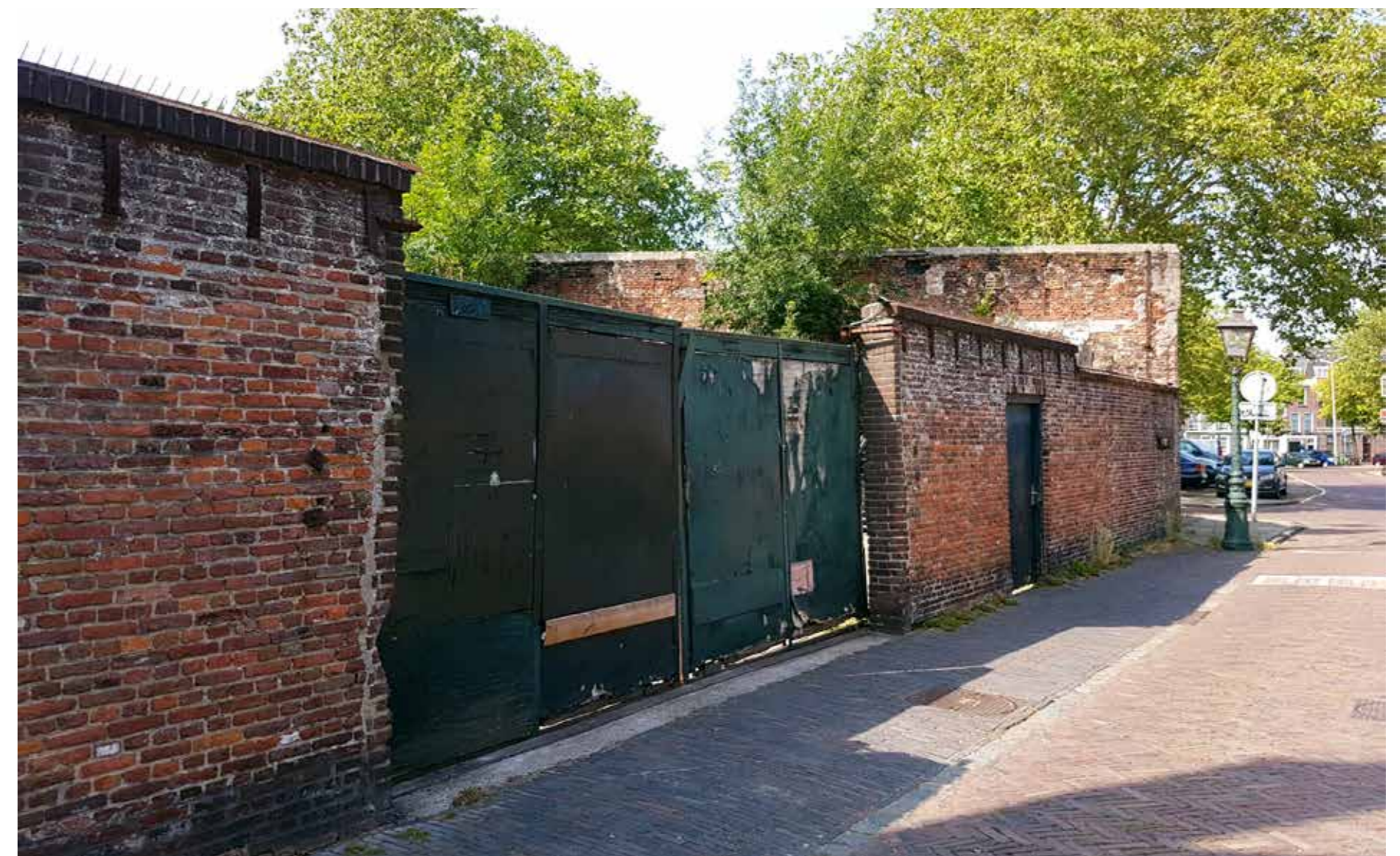
Het ommuurde stukje grond tussen de Kaasmarkt en de Middelweg wordt nu gebruikt voor stalling van autowrakken en opslag van bouwmaterialen.
