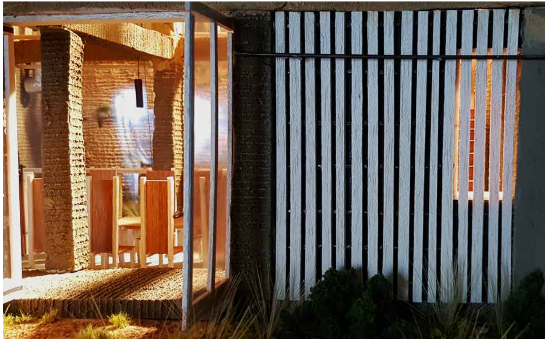
Het gebouw is naar binnen gekeerd, maar sluit zich nooit geheel af van de buitenwereld. Door op meerdere plaatsen ramen achter de gevelbekleding op te nemen is er wel zicht naar buiten, maar wordt inkijk voorkomen.
